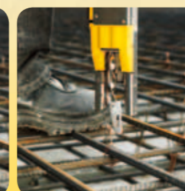
3 Istovjetnim povlačenjem: spojnica se uvija.
