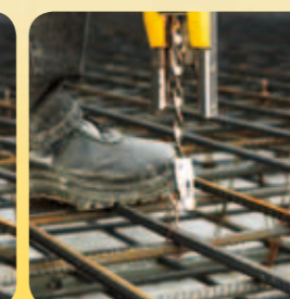
4 Dalje povlačite do automatske točke okidanja: spajanje je sada čvrsto.
