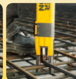
2 Lagano pritisnite: spojnica obuhvaća armaturu.
